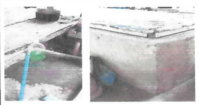
Foto 2: Remodelacion de pila (cubierta de azulejos)
